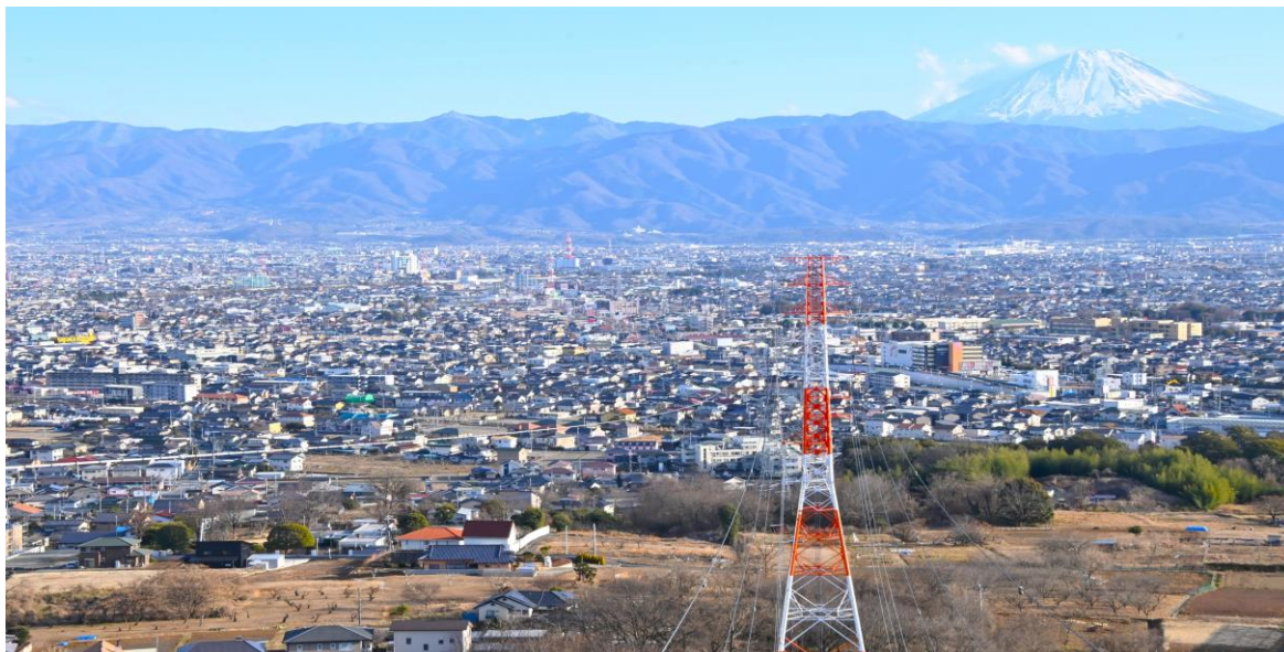
送電線の電線点検
