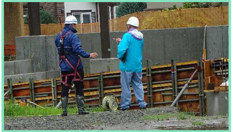
ゾウ舎周辺基礎工事を確認
