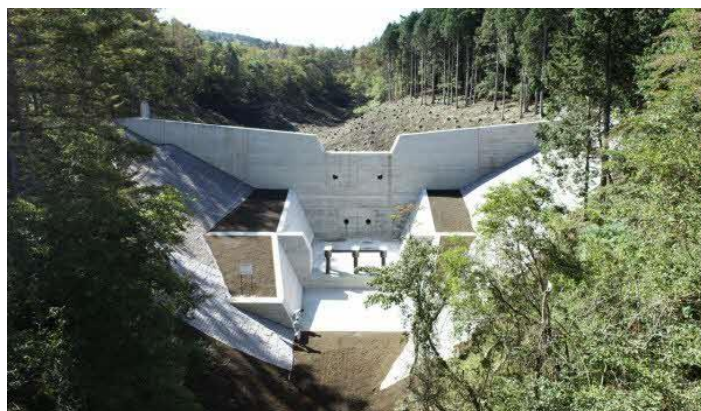
朝沢砂防工事
