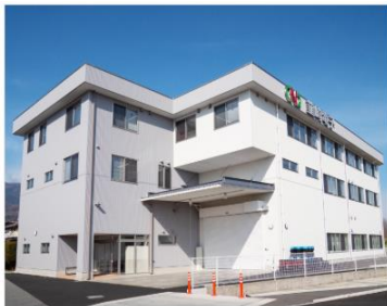
本社第一工場
