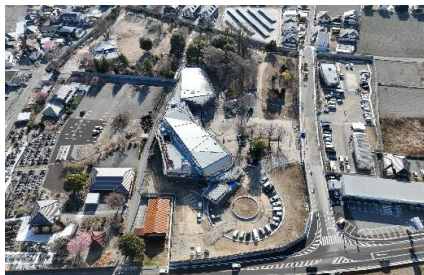
R7年度土木完成写真
