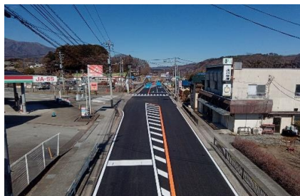
R7年度舗装完成写真
