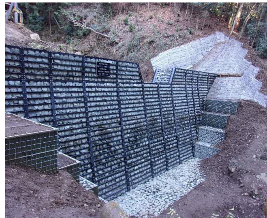
施工事例 (鋼製谷止め工)
