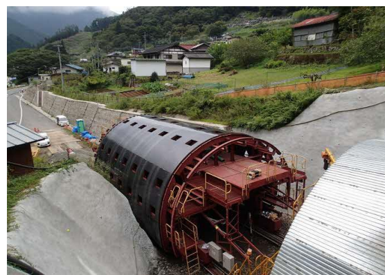
施工状況 (トンネル セントル組立中)
