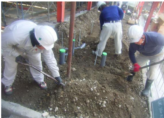
伊勢小学校施工状況
