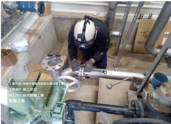
県営住宅千塚団地施工状況
