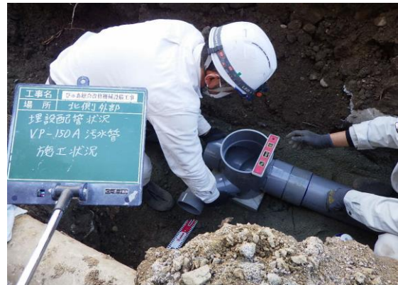
ぴゅあ総合施工状況
