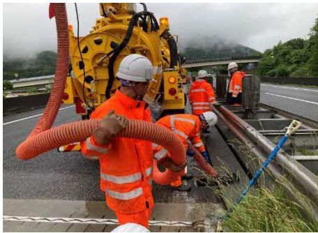
路面排水溝清掃作業
