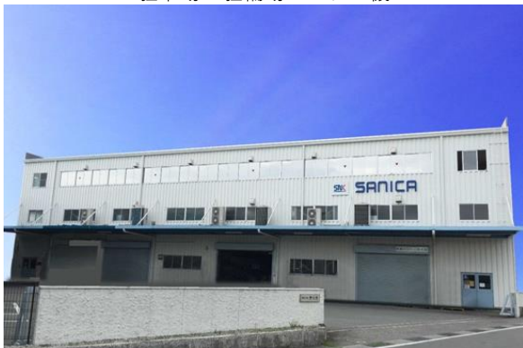
本社工舎(南アルプス市)
