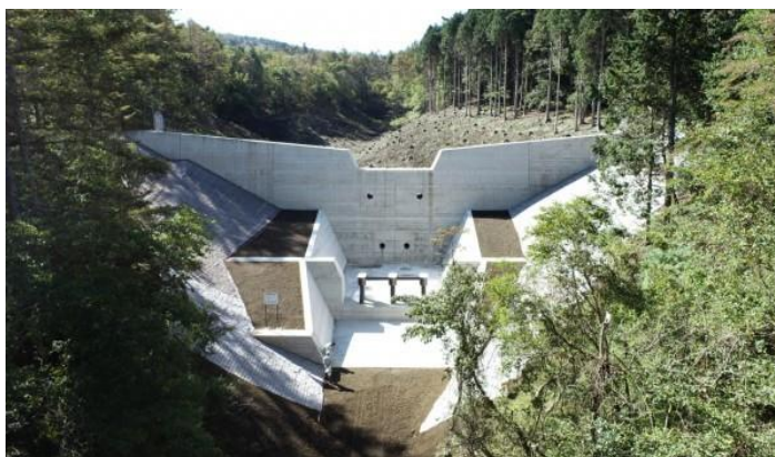
朝沢砂防工事
