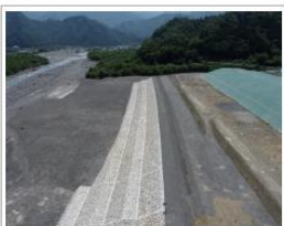
R2栗倉地区改良（その5）工事
