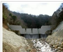
石空川第2砂防堰堤工事
