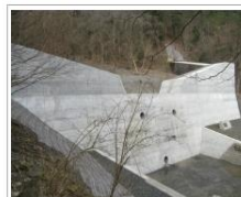
唐沢砂防堰堤補強工事
