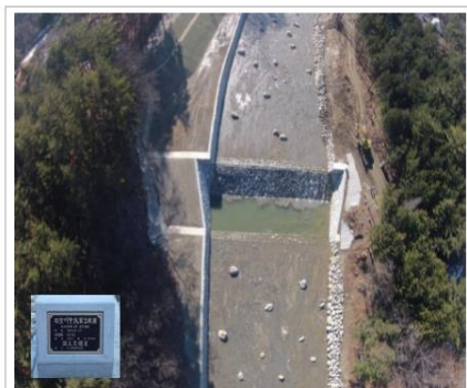
石空川中流第3床固工事
