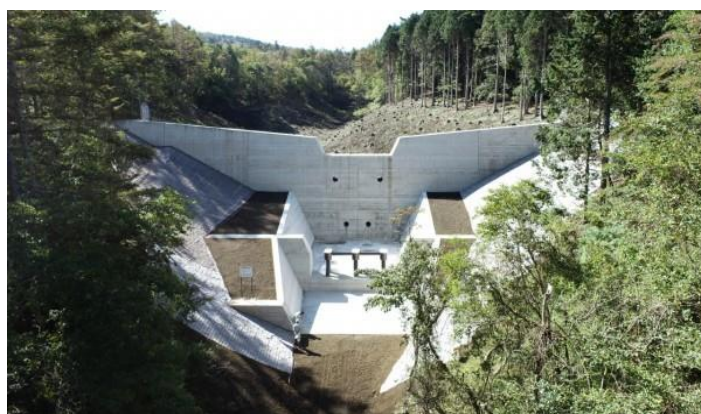
朝沢砂防工事
