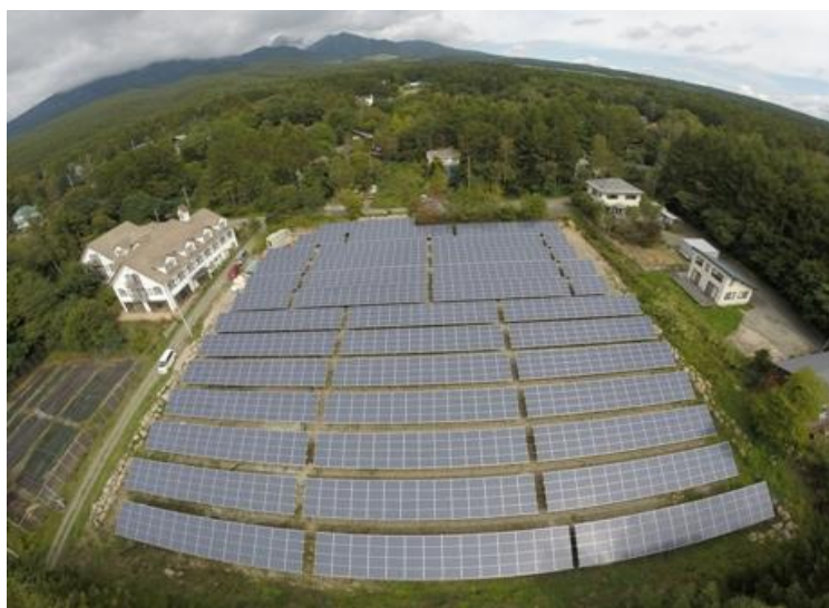
当社管理太陽光発電設備（北杜市）
