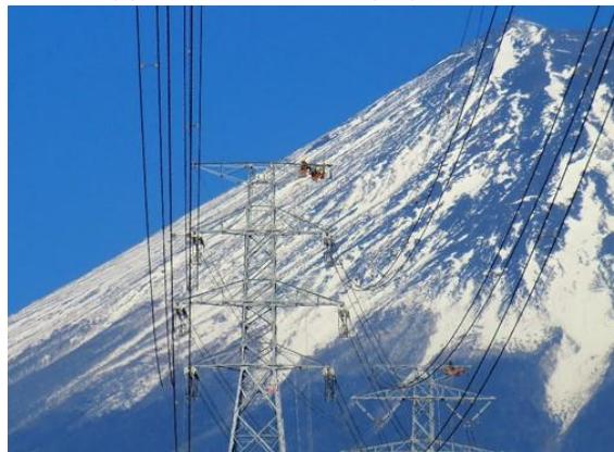
【施工管理風景】電線架線作業
