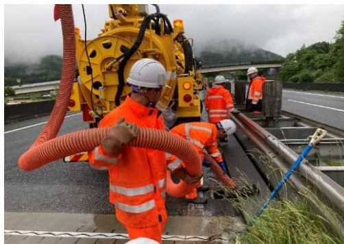
路面排水溝清掃作業
