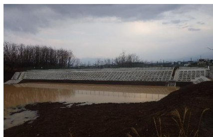
R6年度土木完成写真
