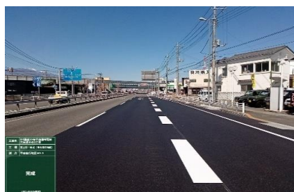
R6年度舗装完成写真
