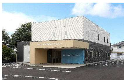
R6年度建築完成写真
