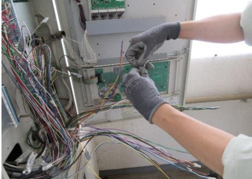
火災受信機内配線結線中
