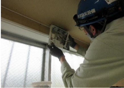
誘導灯交換中
