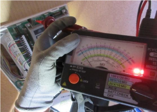
火災受信機絶縁抵抗測定中
