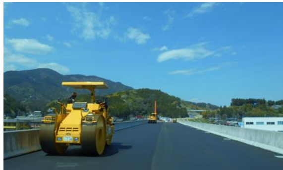
中部横断自動車道舗装工事
