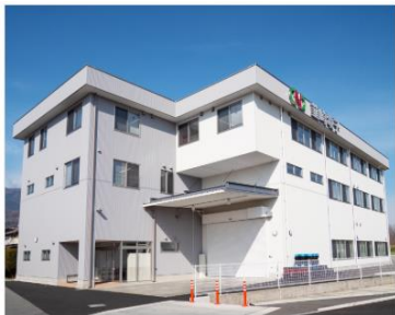
本社第一工場
