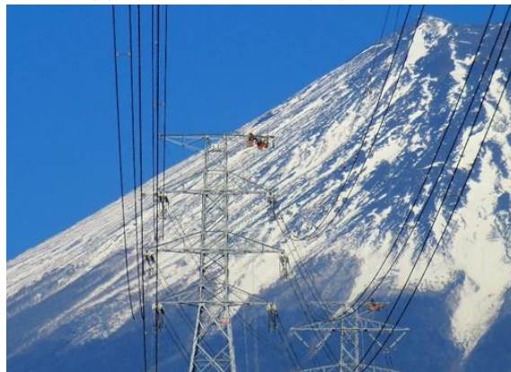
【施工管理風景】電線架線作業
