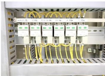
最新の設備や高機能、高性能な自動機はありません。太陽電機のモノ作りの強みは、ずばりヒト。確かな技術を備えた人材です。デジタル製品と違い、制御盤や配電盤などの重電機器は、生産の自動化が難しく、今でもヒトの手によって組立配線が行われています。そのため配線作業者のスキルの有無が、配線の美しさに現れます。但し残念ながら美しい配線（フォーミング）は、機器内部に隠れてしまうため、普段その姿を目にすることはありません。しかし目に見えない部分も妥協することなく、こだわりを持ったものづくりを実践しています。
