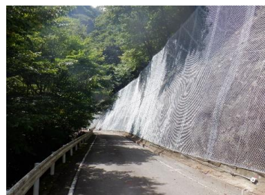
法面保護（落石防護）
