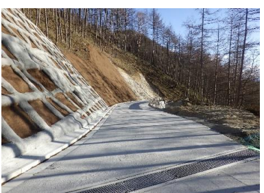
林道開設（コンクリート舗装）
