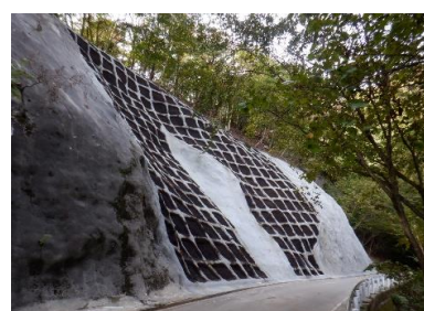
法面保護（植生吹付）
