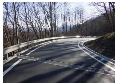
林道開設（アスファルト舗装）
