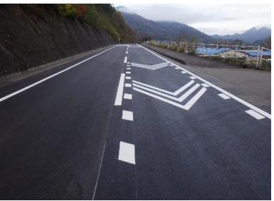
アスファルト舗装
