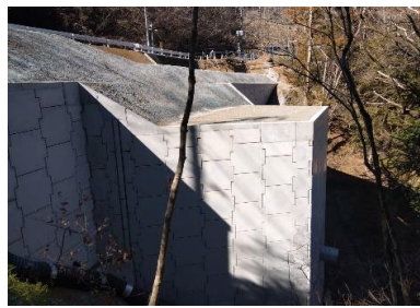
道路改良（歩道拡幅）
