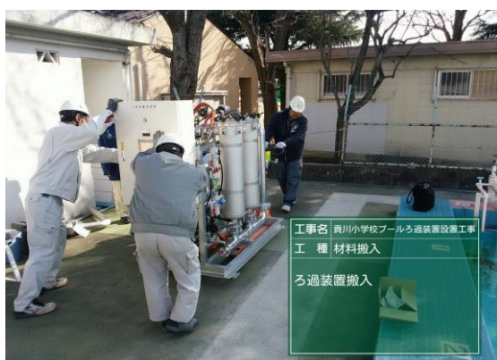
貢川小学校施工状況
