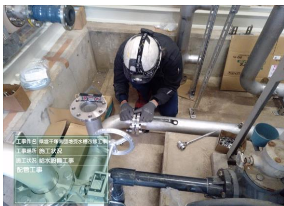
県営住宅千塚団地施工状況
