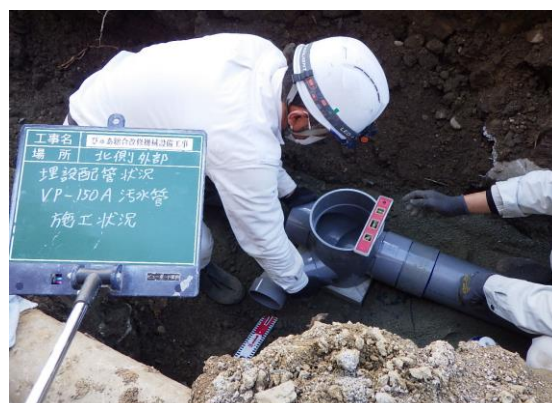
ぴゅあ総合施工状況
