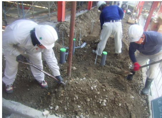
伊勢小学校施工状況
