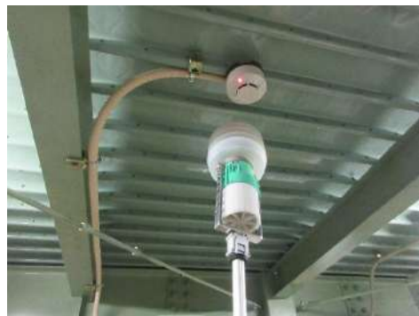
煙感知器作動試験中
