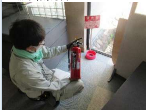
消火器点検中
