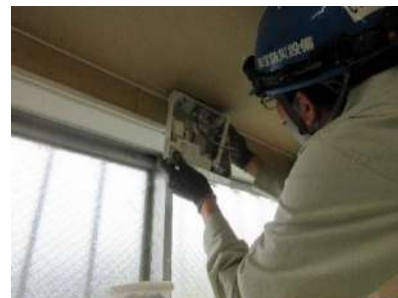
誘導灯交換中
