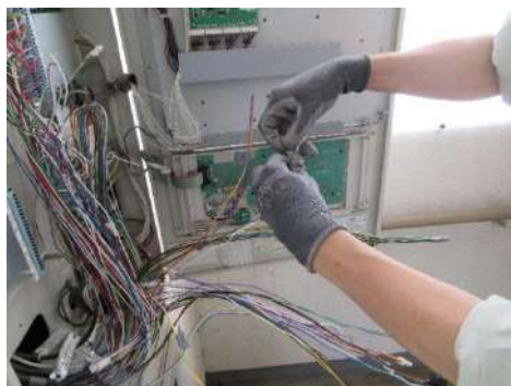
火災受信機内配線結線中
