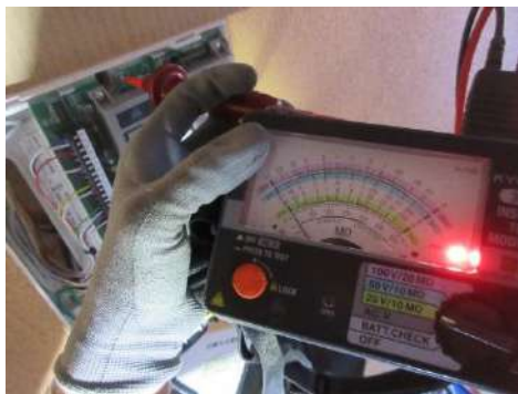
火災受信機絶縁抵抗測定中
