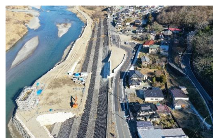
富士橋橋梁下部(A1橋台)工事
