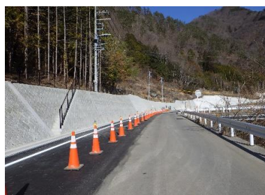
笛吹市川三郷線道路改良工事
