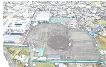
青洲高校グラウンド整備工
