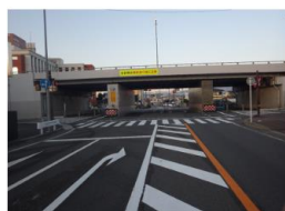
H28国母立体橋耐震補強その1工事 現場代理人兼監理技術者表彰
