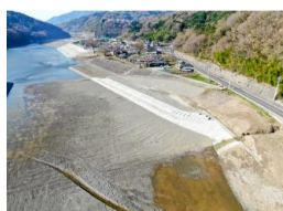
R1富士川右岸手打沢上護岸工事 新技術等活用実績表彰【事務所長表彰】
