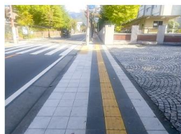
(主) 甲府山梨線歩道補修工事 (明許)
