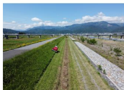
R2富士川上流維持工事 優良工事表彰【局長表彰】
