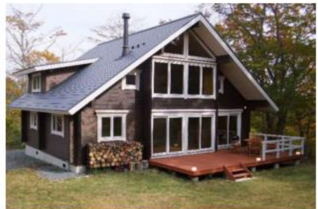
施工例（ログハウス）
