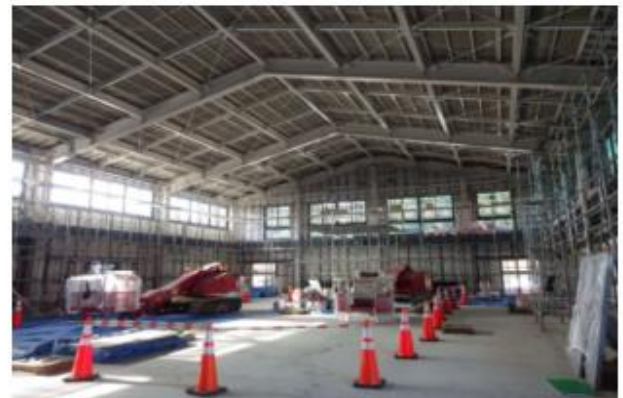
施工例（屋内運動場）
