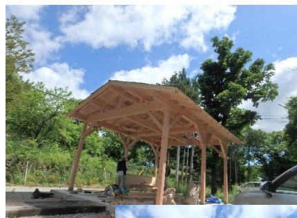
バーベキュー施設建築 現場管理
