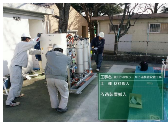
貢川小学校施工状況
