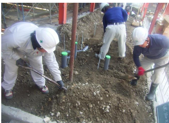
伊勢小学校施工状況
