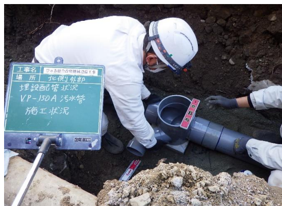
ぴゅあ総合施工状況
