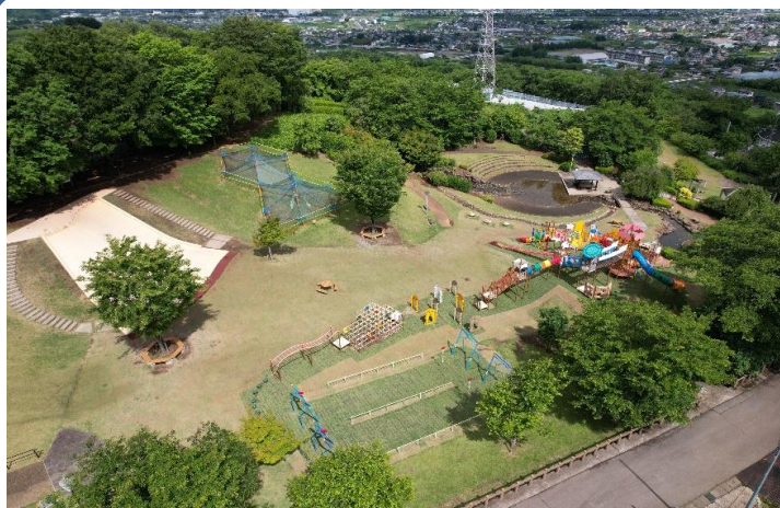
令和5年度 八代ふるさと公園遊具更新工事
