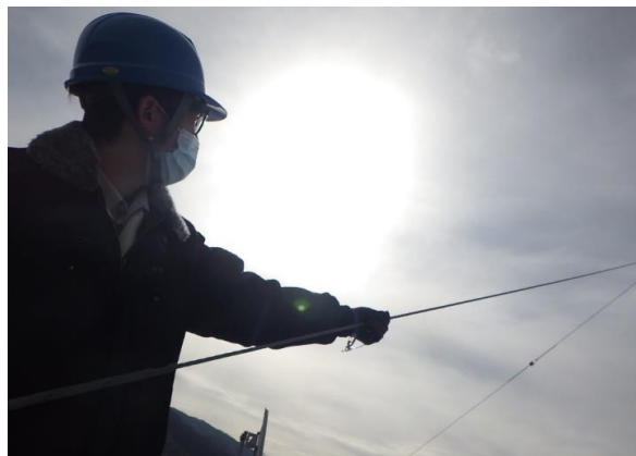
消防設備工事
