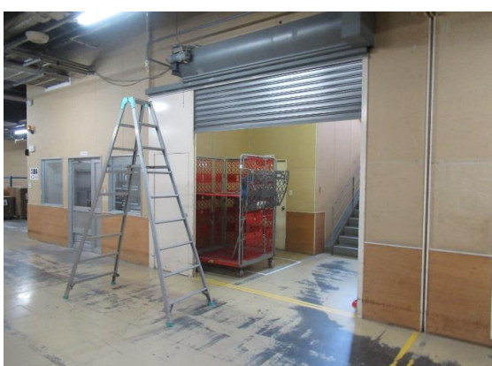
防火シャッター点検
