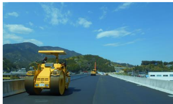
中部横断自動車道舗装工事
