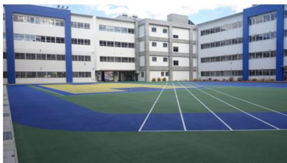
都留興譲館高校中庭工事
