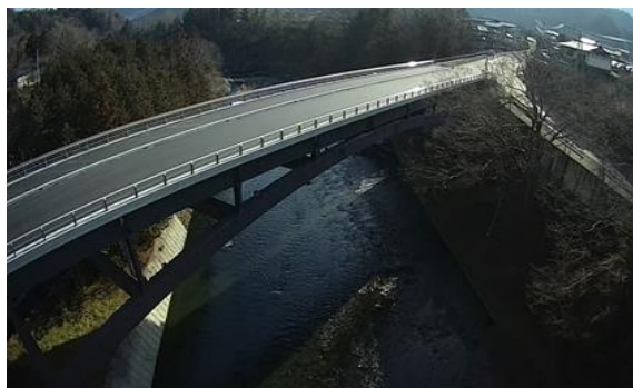
県道高畑谷村停車場線新院辺橋床版工事
