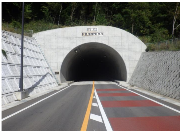
金井トンネル
