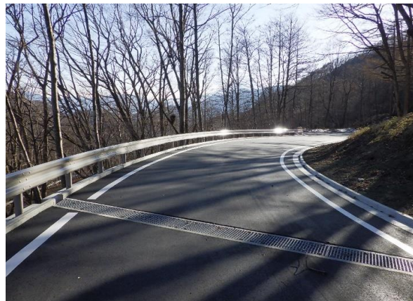
林道開設 真木小金沢線
