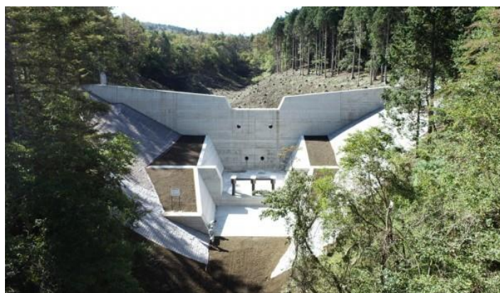
朝沢砂防工事
