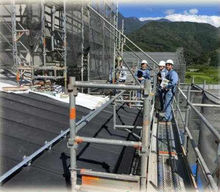
建設現場パトロール
