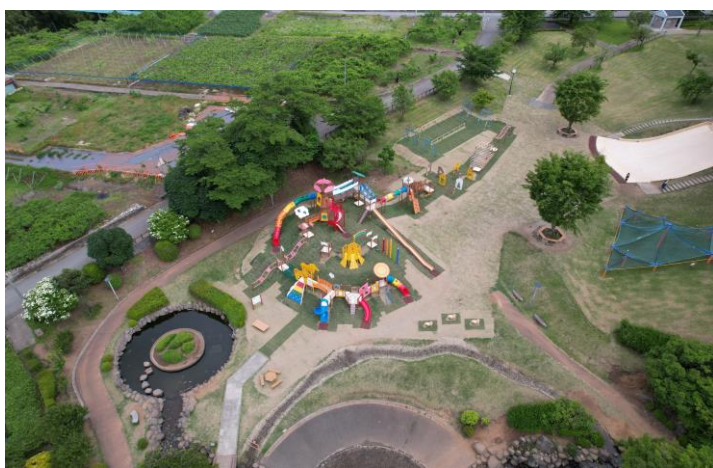
令和5年度 八代ふるさと公園遊具更新工事
