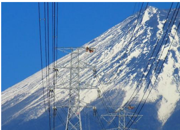
【施工管理風景】電線架線作業
