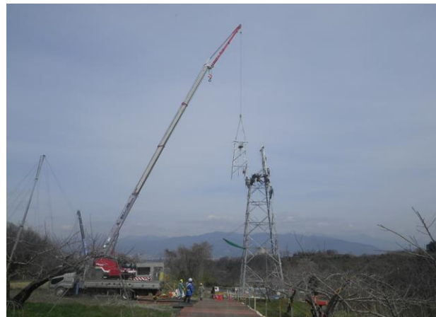
【施工管理風景】鉄塔組立作業
