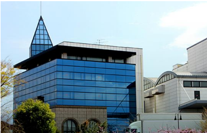
南アルプスワインアンドビバレッジ 工場外観
