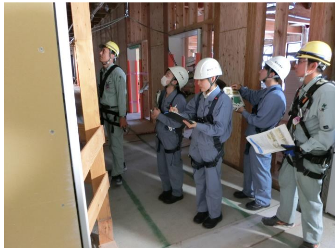
建設現場パトロール①
