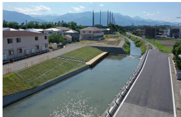
河川改修工事
