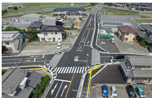
道路改良工事
