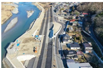
富士橋橋梁下部(A1橋台)工事
