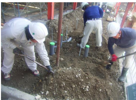
伊勢小学校施工状況
