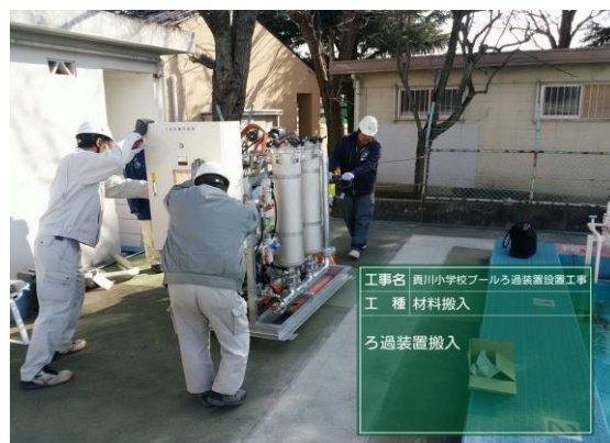
貢川小学校施工状況
