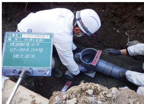
ぴゅあ総合施工状況
