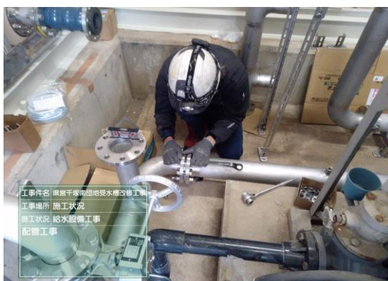
県営住宅千塚団地施工状況
