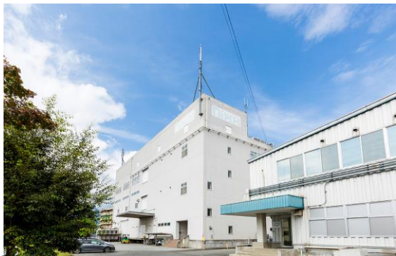
ニックス株式会社南アルプス工場の社屋です。 1986年より操業中です。
