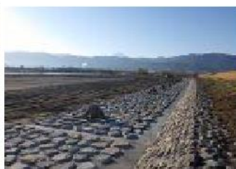
土木完成写真
