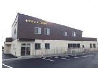
建築完成写真
