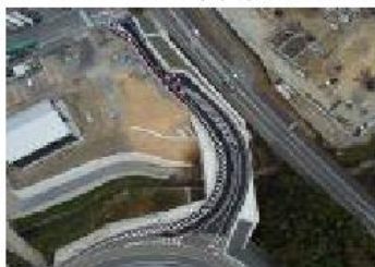
土木完成写真
