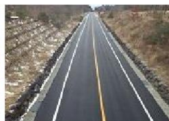
舗装完成写真
