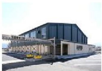
建築完成写真
