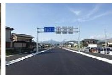
舗装完成写真
