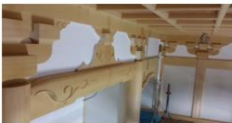
寺院内部壁しっくい仕上げ
