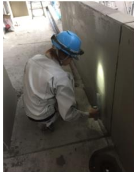
先輩の雄姿（マンション現場）
