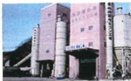
甲府市滝田建材株式会社の 生コンクリート製造工場
