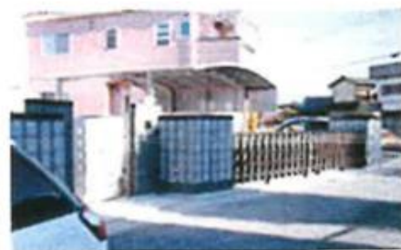
甲府市滝田建材株式会社の エクステリア設計施工
