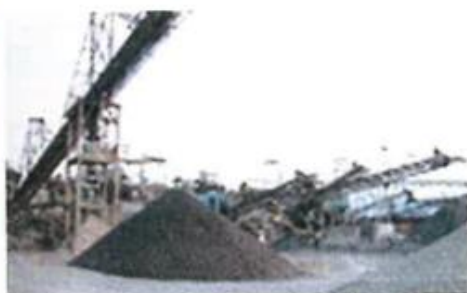
甲府市滝田建材株式会社の砕 石・砕砂製造工場
