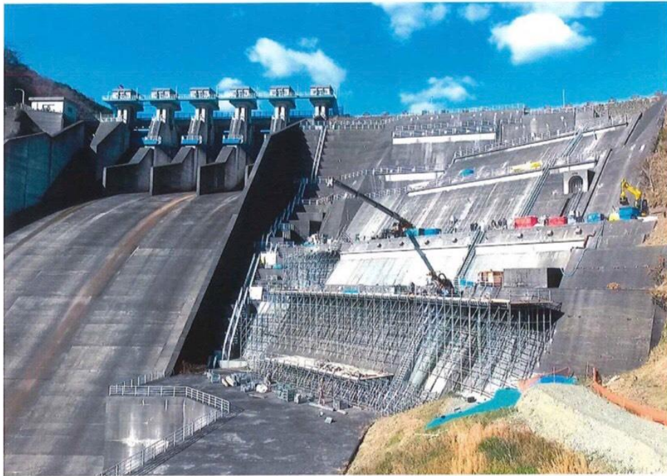
平成30年度 三保ダム地山アンカー更新工事（3工区）
