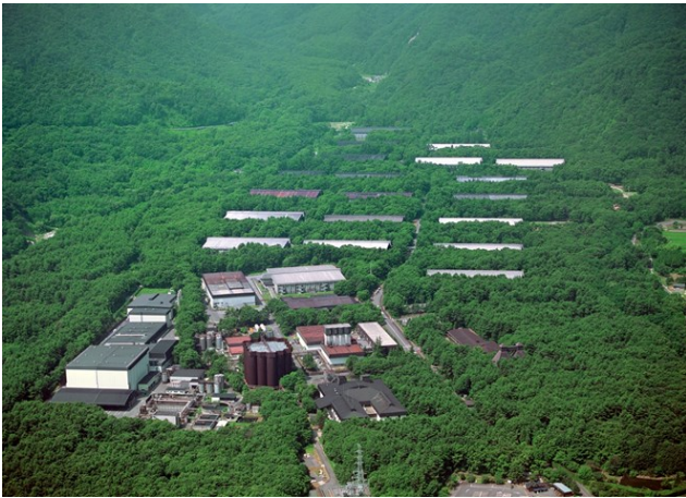
工場全体風景
