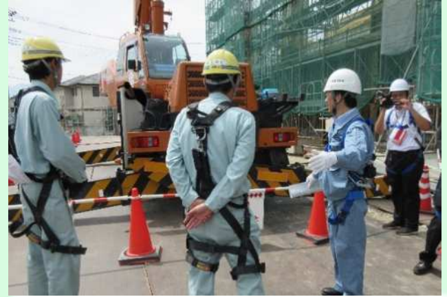
クレーン等災害防止対策の確認
