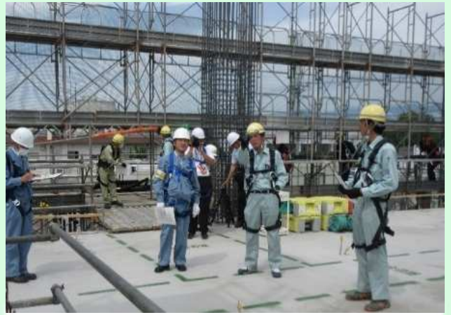
現場内・足場の設置状況等の確認
