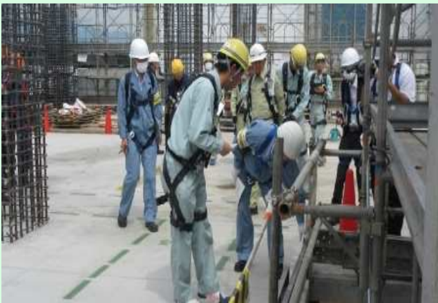
墜落防止等の安全対策の確認
