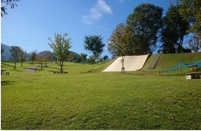
八代ふるさと公園拡張整備工事
