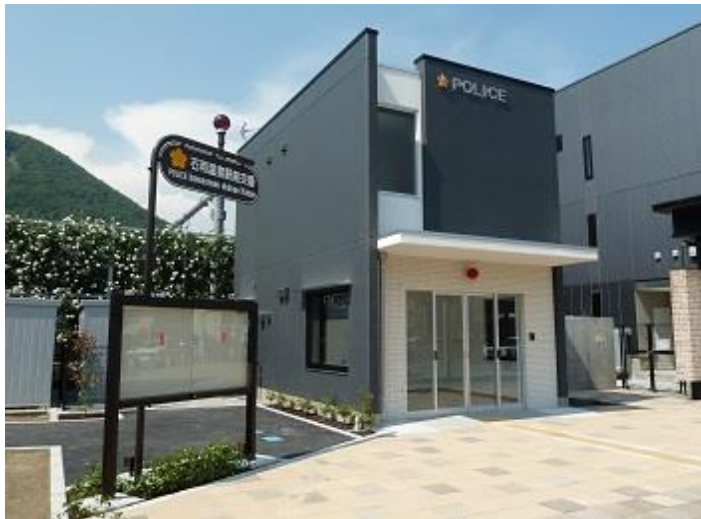
石和温泉駅前交番建設工事
