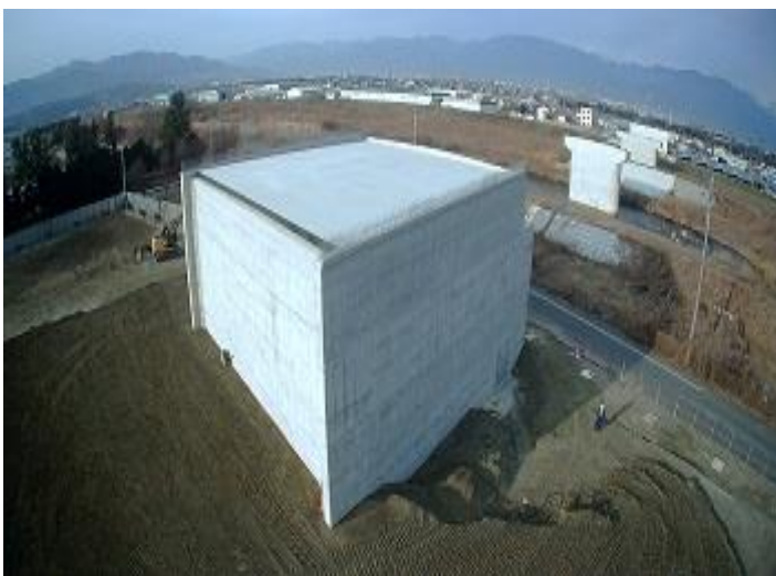
国道140号濁川・平等川橋下部工事 (JV)
