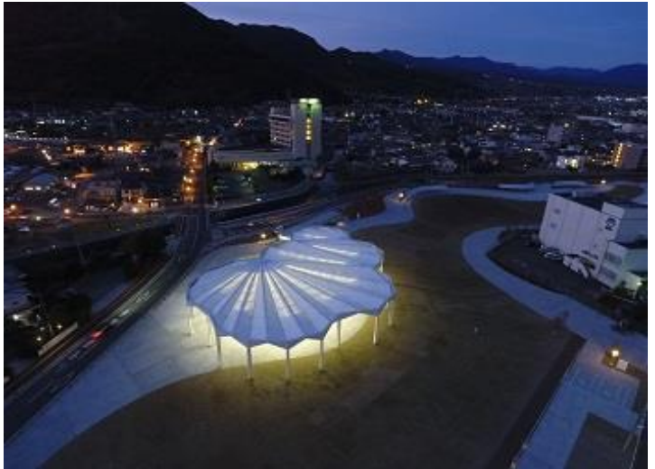
笛吹みんなの広場整備工事 (JV)
