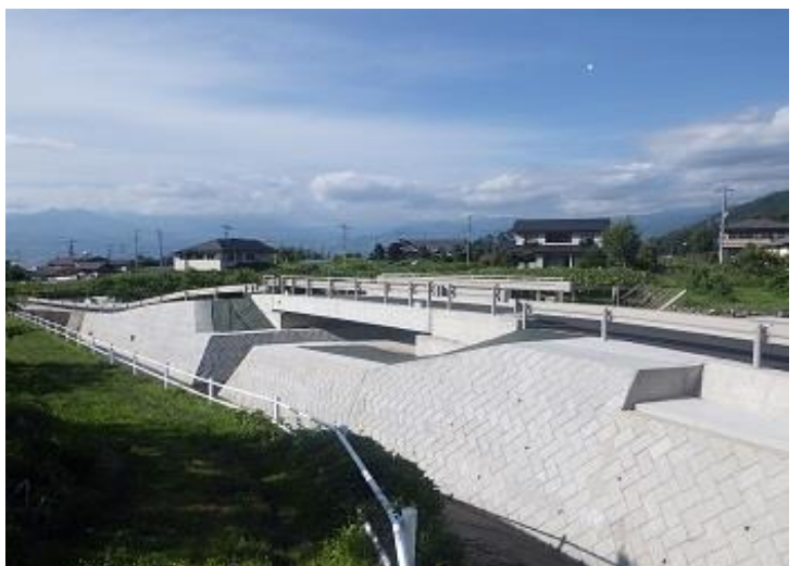
黒駒西地区農道5号道路工事
