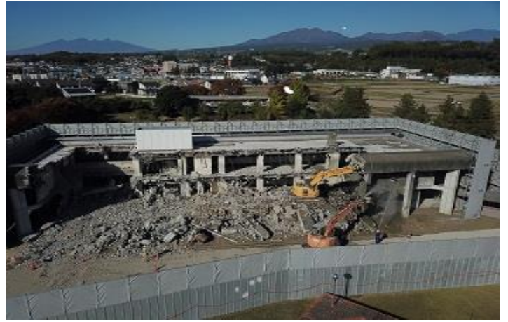
農業技術センター北館解体工事
