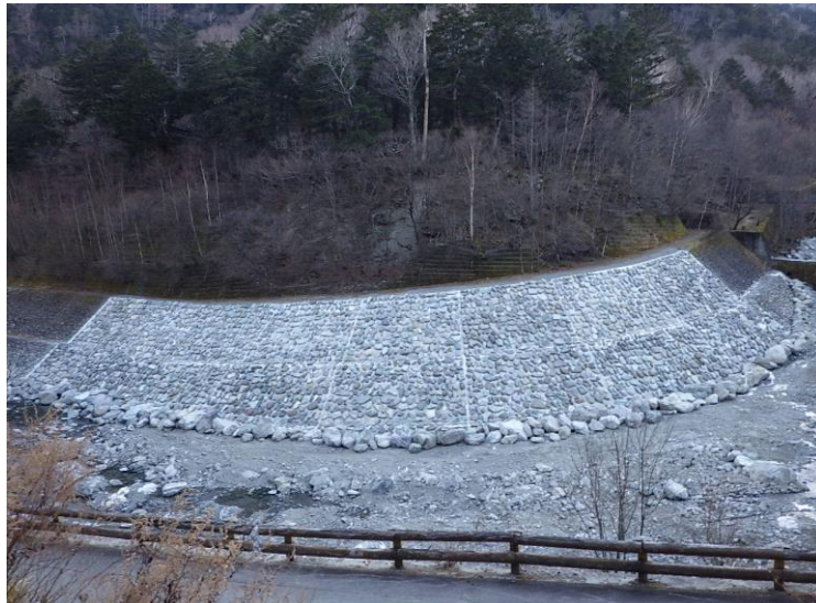
R2広河原上流護岸災害復旧工事
